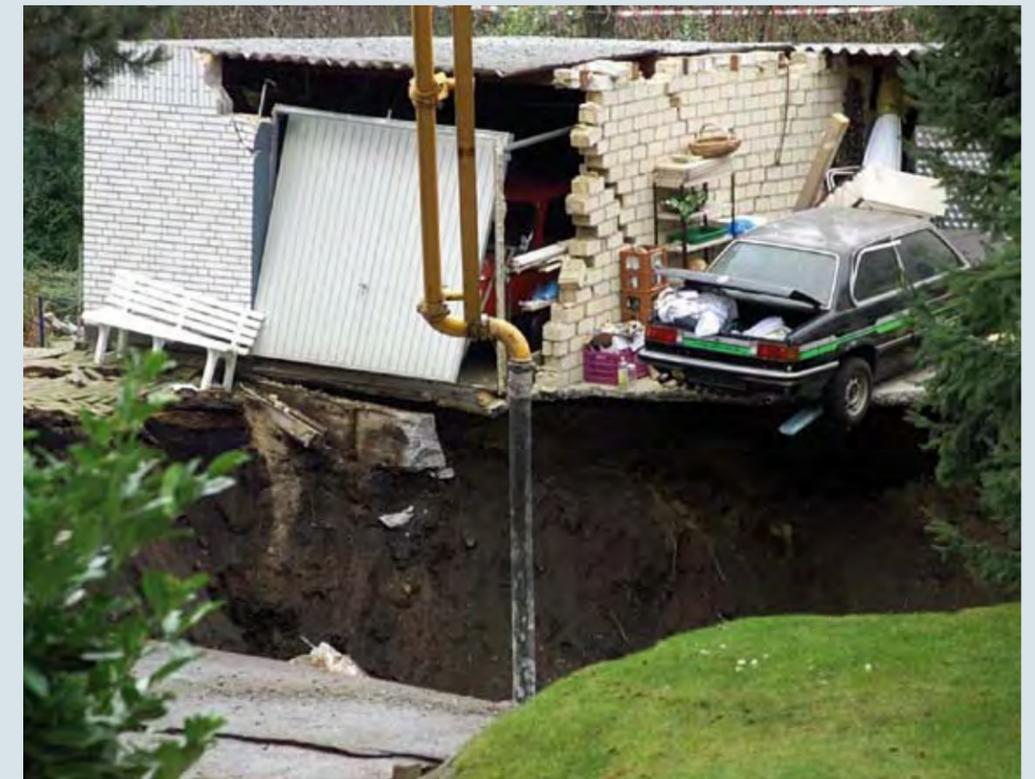
Der Bergbau hinterlässt nicht nur „oberflächlich“ seine Spuren: Nach einem sogenannten Bergschaden in einem Wohngebiet in Bochum-Wattenscheid war eine Garage in einem 40 mal 40 Meter tiefen Loch verschwunden (Aufnahme 2000). Das Erdreich über einer ehemaligen Schachanlage hatte plötzlich nachgegeben, die Anwohner mussten evakuiert werden.
